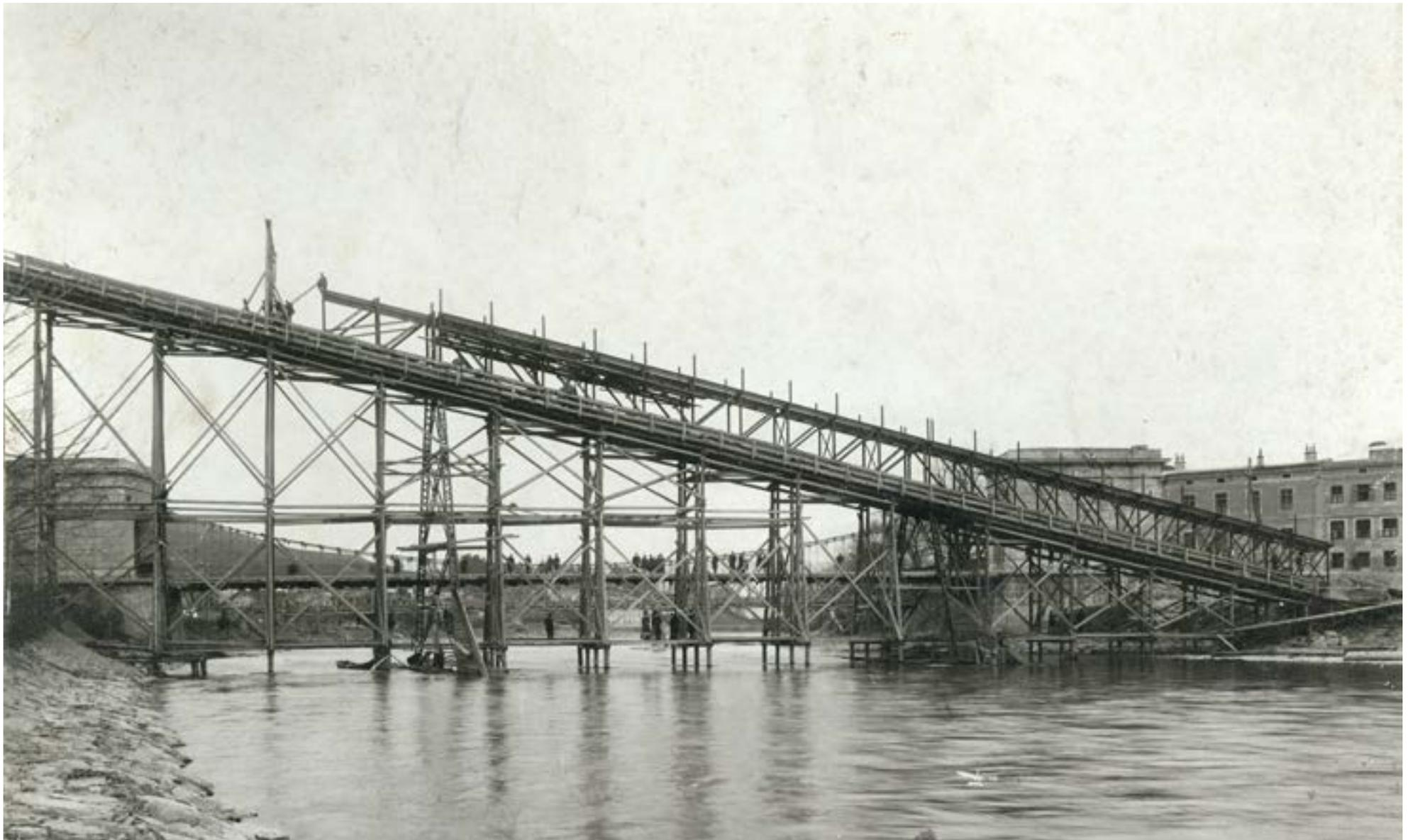
Der Bau der Hungerburgbahn begann im Februar 1906. Auf einem Holzgerüst wurde die Stahlbrückenkonstruktion über den Inn montiert. Nur 7 Monate später erfolgte die Inbetriebnahme der Bahn. Nicht nur die 158 m lange Brücke, sondern vielmehr die Hungerburgbahn als Gesamtwerk kann man für die damalige Zeit berechtigterweise als „technisches Meisterwerk“ bezeichnen. Fotoquelle: Dr. Dieter Tausch Antiquariat
