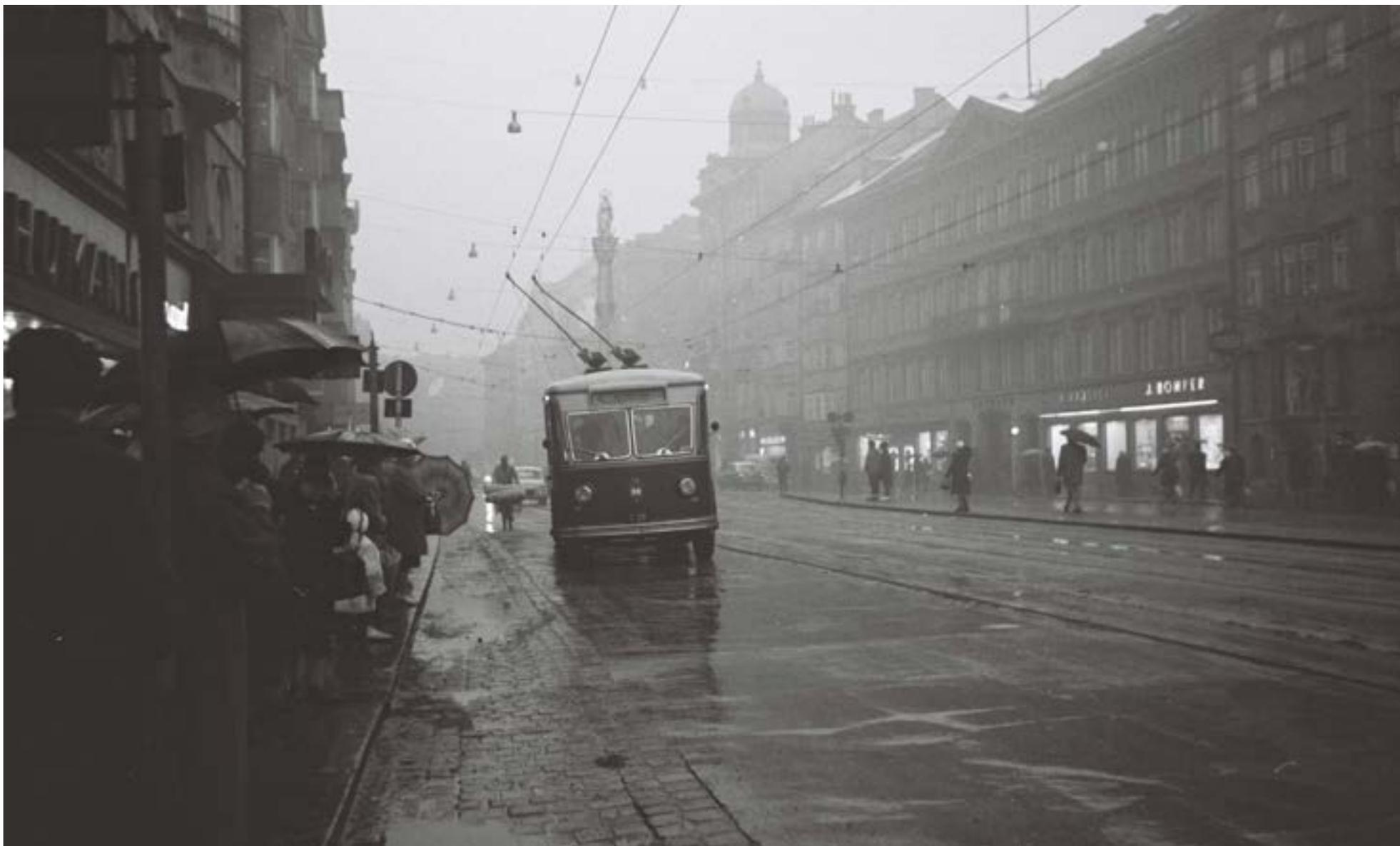
Die Linie C war Innsbrucks erste O-Bus-Linie und verkehrte ab April 1944 zwischen Wilten und Arzl – also auch durch Mühlau. Anlass für die Einführung von Oberleitungsbus-Linien in Innsbruck war „der kriegsbedingte Treibstoffmangel“. Das Bild zeigt einen O-bus (FIAT) der Linie C im Jahr 1962 bei der Anfahrt der Haltestelle in der Maria-Theresien-Straße. Die Linie C wurde noch bis ins Jahr 1971 als O-bus geführt.
