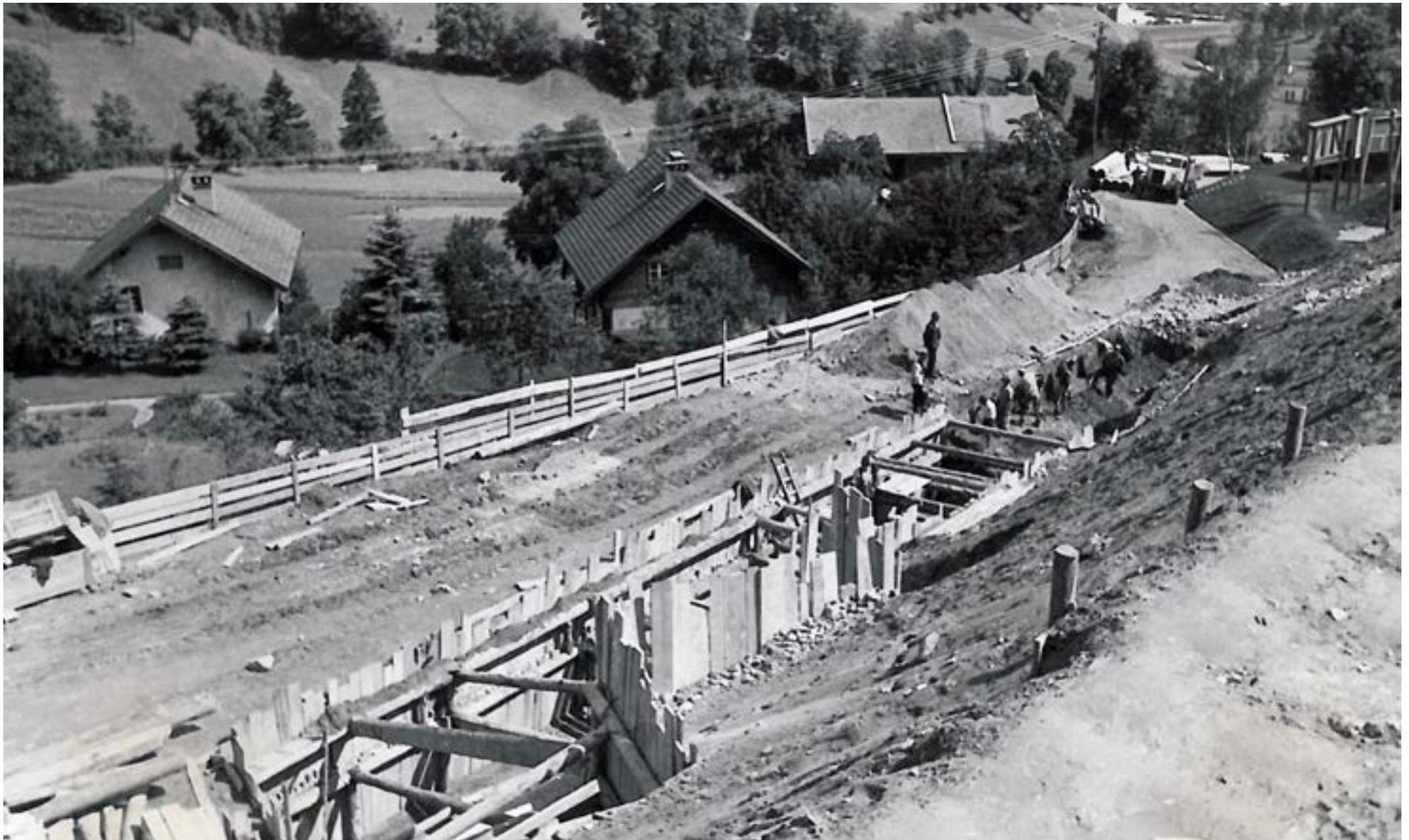
1953 wurde das Trinkwasserkraftwerk am Schillerweg feierlich in Betrieb genommen. Zu den vorangegangenen umfangreichen Baumaßnahmen gehörte auch der Neubau der Trinkwasserleitung. Wir sehen einen Teil der Baustelle im oberen Teil der Josef-Schraffl-Straße.
