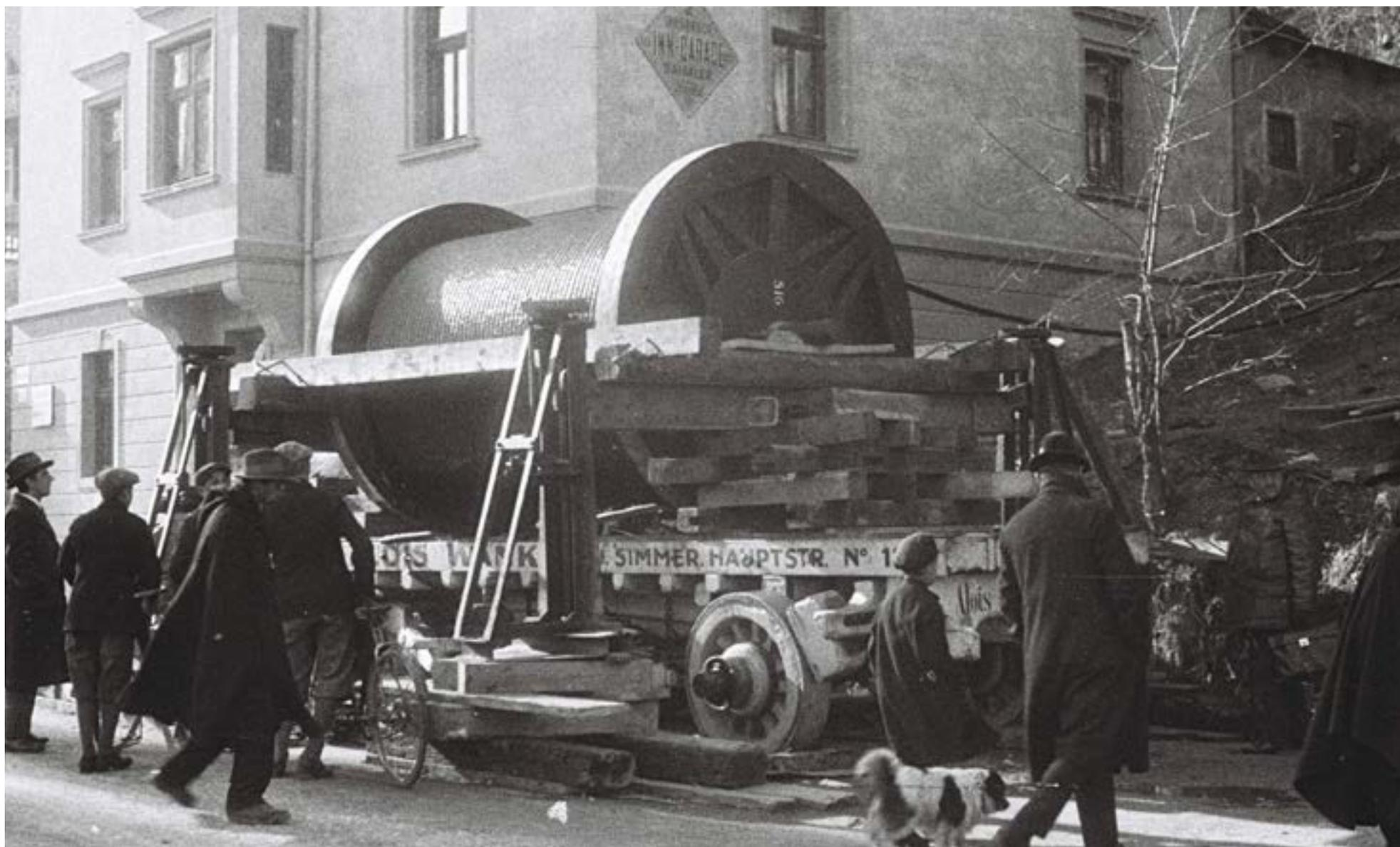
1928 wurden die schweren Trag- und Zugseile für die Nordkettenbahnen mit der Eisenbahn zur Rauchmühle und von dort auf der Straße weiter bis zum Hohen Weg transportiert. Von dort aus zog man die Seile auf einer eigenen Behelfs-Trasse über Hilfsstützen bis zur Hungerburg und weiter zur Seegrube hinauf. Wir sehen auf diesem Bild vermutlich eines der Tragseile der Sektion Hungerburg-Seegrube.
