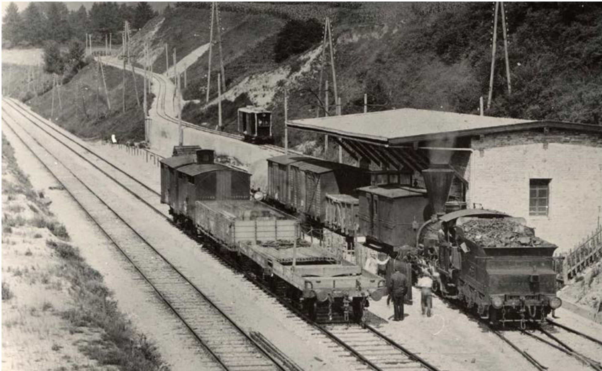
Die Gleisanlage zur alten Rauch-Mühle: Während die Güterzuggarnitur noch mit Dampf betrieben wurde, fuhr der schmalspurige Triebwagen der Rauch-Mühle bereits ab 1900 hochmodern elektrisch. Leopold Rauch ließ die 1,2 km lange Lokalbahn für den Getreide- und Mehtransport von dieser Verladerrampe bis zur alten Rauch-Mühle am Mühlauer Bach auf firmeneigene Kosten erbauen. Es war die erste elektrische Bahn Tirols.
